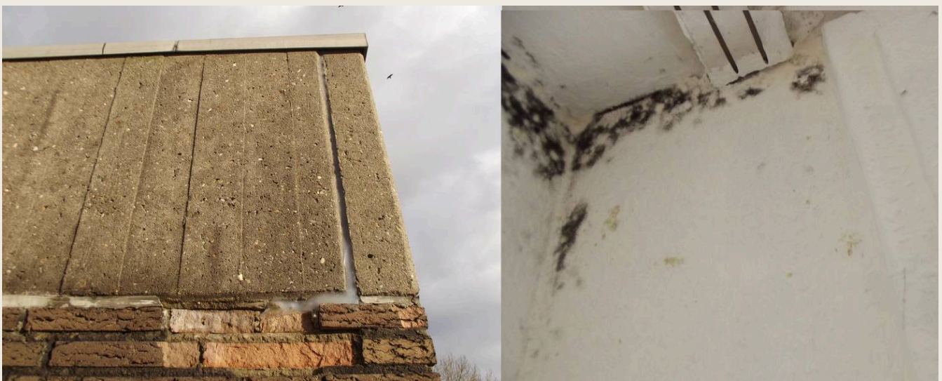
FIG. 03 · MOULD IN A ROOM CORNER · PHOTO: NordhornerII / WIKIMEDIA COMMONS · CC BY-SA 4.0. Source and licence
