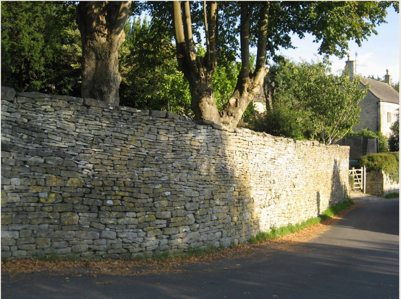
FIG. 06 · COTSWOLD DRY-STONE WALL · PHOTO: JONGLEUR100 / WIKIMEDIA COMMONS · PUBLIC DOMAIN. Source and licence
