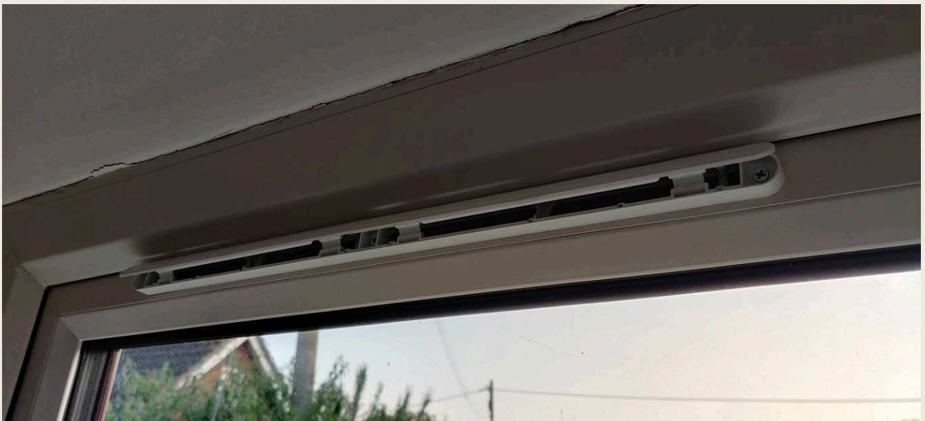
FIG. 03 · OPEN TRICKLE VENT · PHOTO: JAMESKINGDOM / WIKIMEDIA COMMONS · CC BY-SA 4.0. Source and licence
