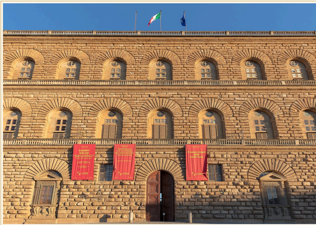
Photo: Diego Delso, via Wikimedia Commons (CC BY-SA 4.0). Source: https://commons.wikimedia.org/wiki/File:Palacio_Pitti,_Florencia,_Italia,_2022-09-18,_DD_197.jpg
